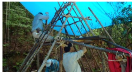
ブルーシートを張って吹き替え作業
